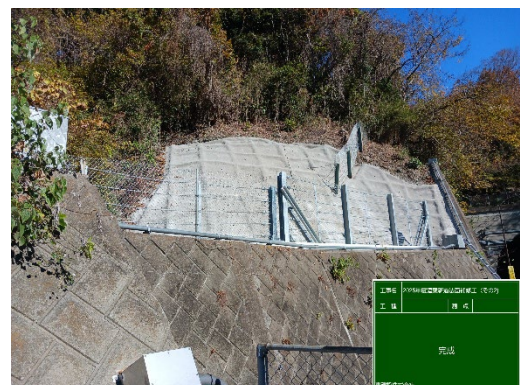
(逗葉新道 法面補修工事(その 2))
