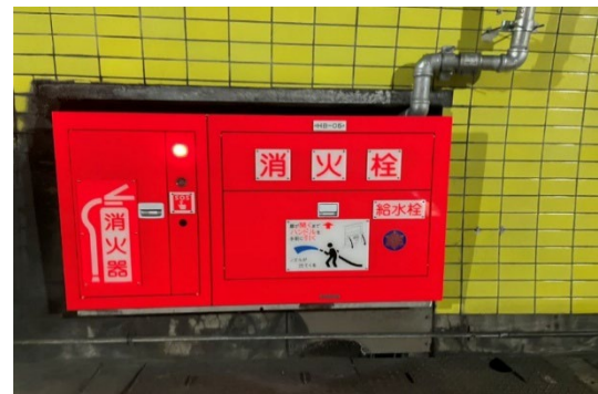
(真鶴道路 トンネル消火栓更新工事)
