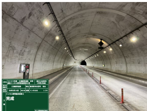
(三浦縦貫道路 衣笠城趾トンネル照明設備更新工事)
