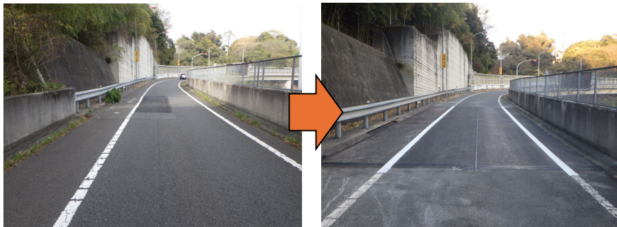
舗装補修実施状況
