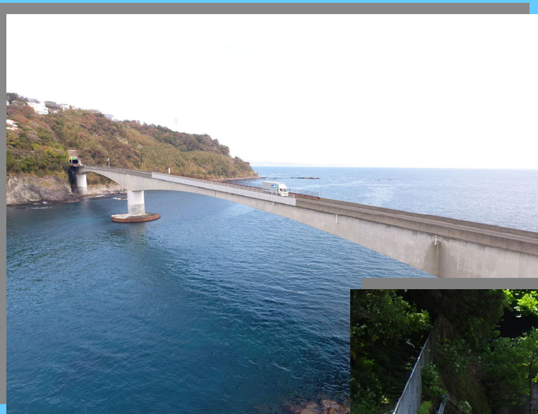
真鶴道路（岩大橋）
