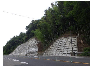
のり面对策（ブロック積み擁壁）
