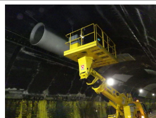
トンネル換気設備の点検
