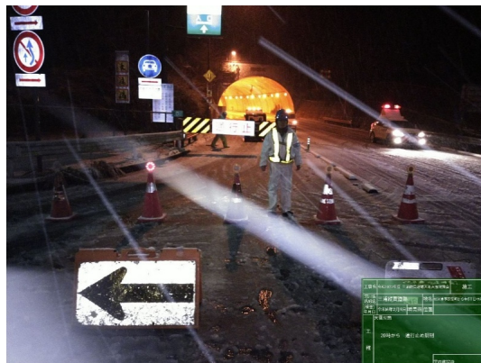
積雪による通行止め実施状況
