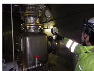
道路排水設備の点検
