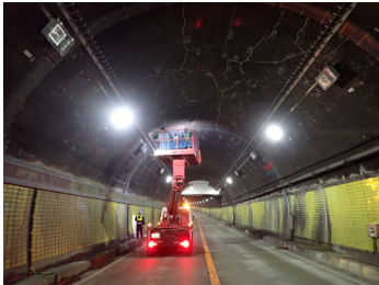
高所作業車による点検
