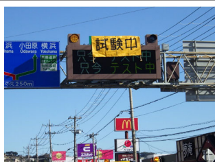
道路情報板の点検
