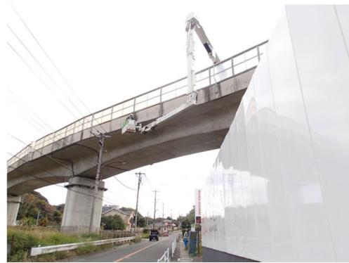
橋りょう点検車による点検
