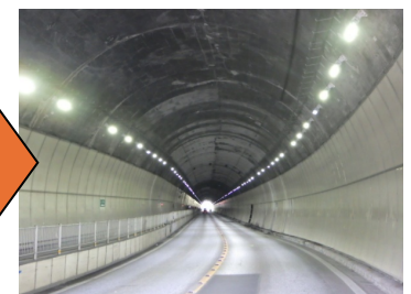
トンネル照明のLED化
