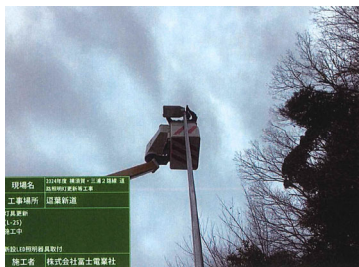
道路照明ランプ交換
