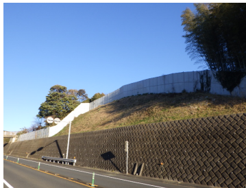
のり面对策（ブロック積み擁壁）
