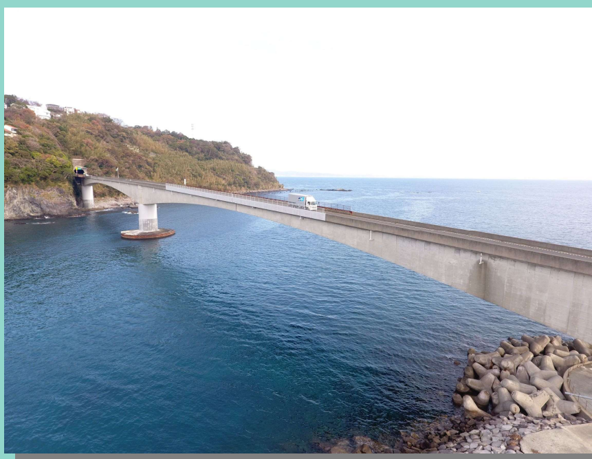
真鶴道路（岩大橋）
