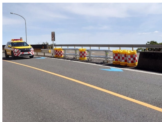
（真鶴道路 非常用出口設置工事）
