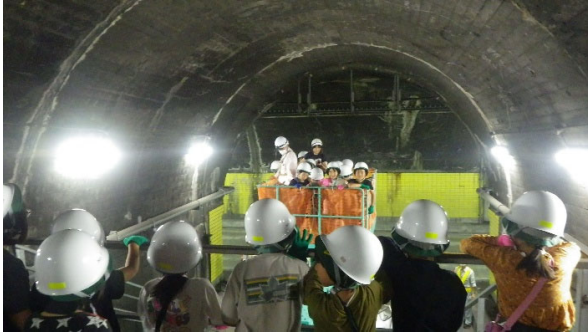
(真鶴トンネル横坑でのリフト車搭乗)
