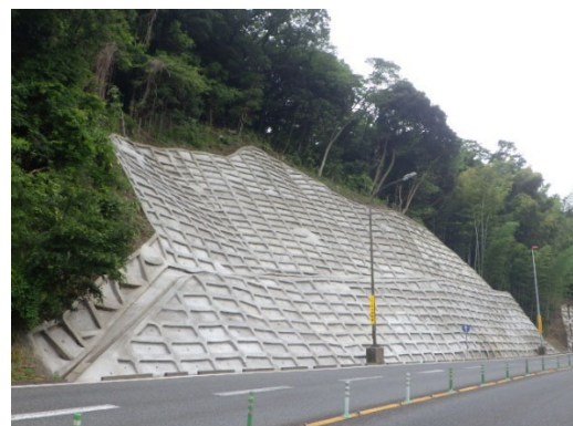
(逗葉新道 法面補修工事)
