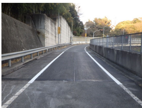
(三浦縦貫道路 舗装補修等工事)
