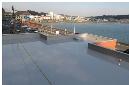
(屋上防水工事)
