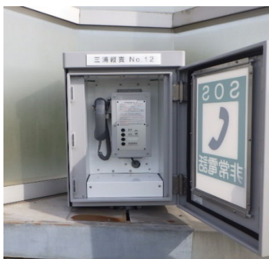
(三浦縦貫道路 非常電話更新工事)
