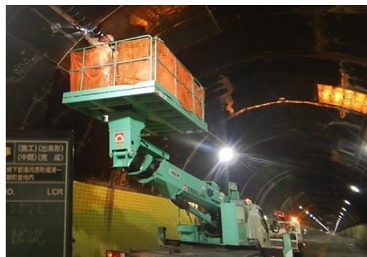
(受託工事 真鶴道路災害防除工事)
