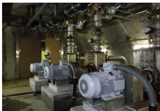
(真鶴道路 排水ポンプ分解整備工事)
