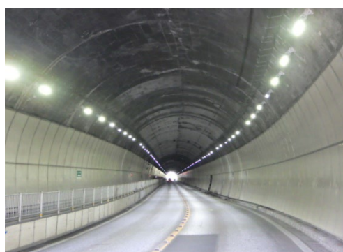
(逗葉トンネル照明設備更新工事)
