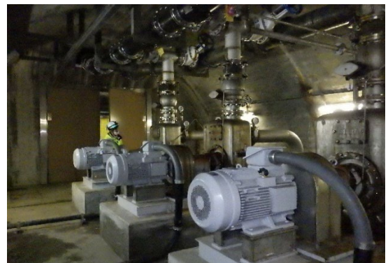
(真鶴道路 排水ポンプ分解整備工事)
