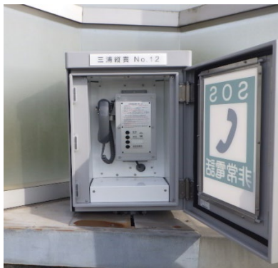
(三浦縦貫道路 非常電話更新工事)
