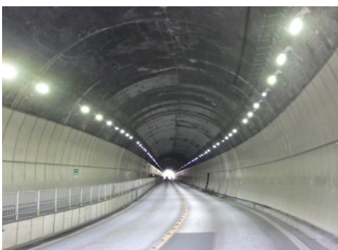
(逗葉トンネル照明設備更新工事)
