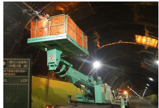
(受託工事 真鶴道路災害防除工事)
