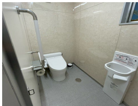
(トイレ設備のリニューアル)
