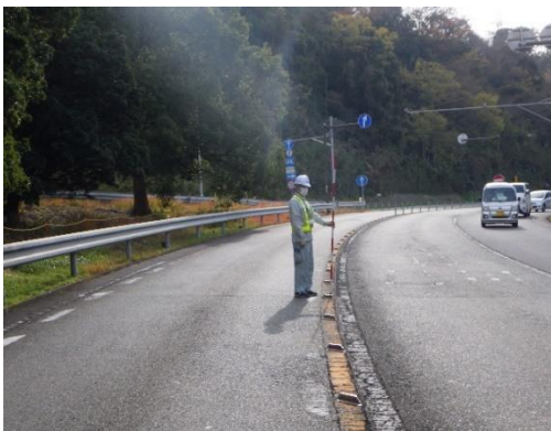
排水性舗装補修工事 施工箇所
