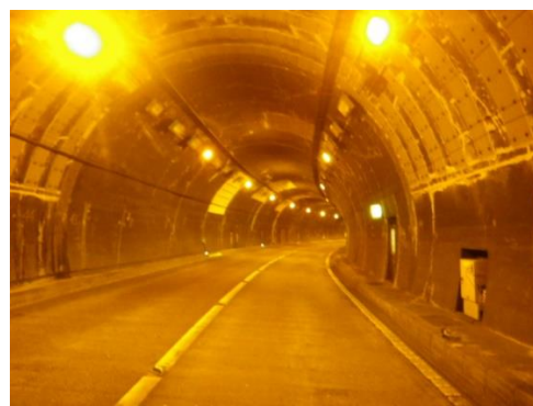
LED照明設備更新工事 施工箇所
