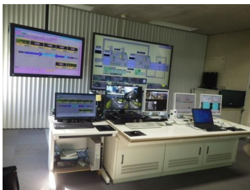
監視制御設備更新等工事 施工箇所
