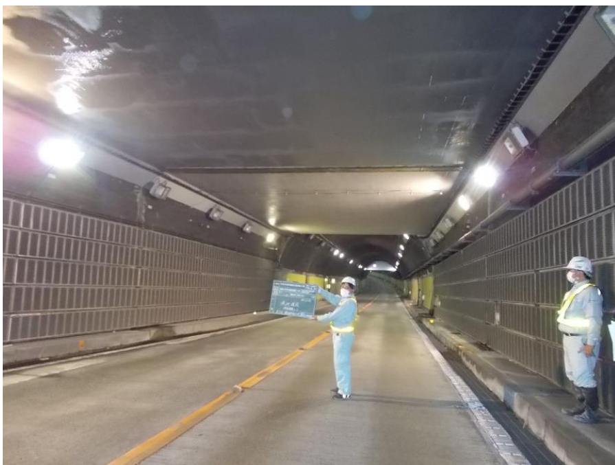
2020（令和2）年度工事完成 道路災害防除工事（真鶴トンネル）
