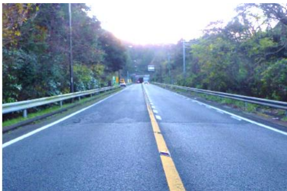
排水性舗装補修工事 施工箇所
