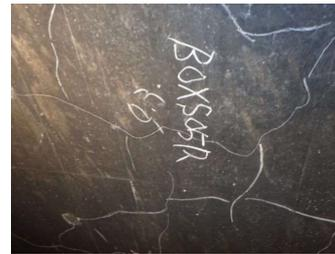
覆工コンクリートのひび割れ
