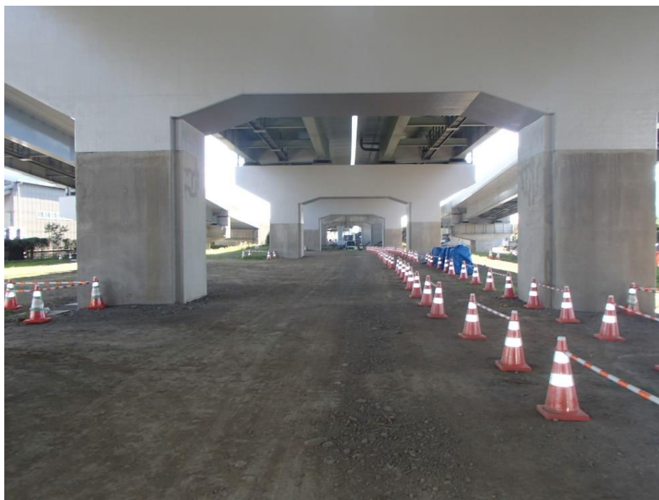
圏央道田端駐車場 整備予定地
