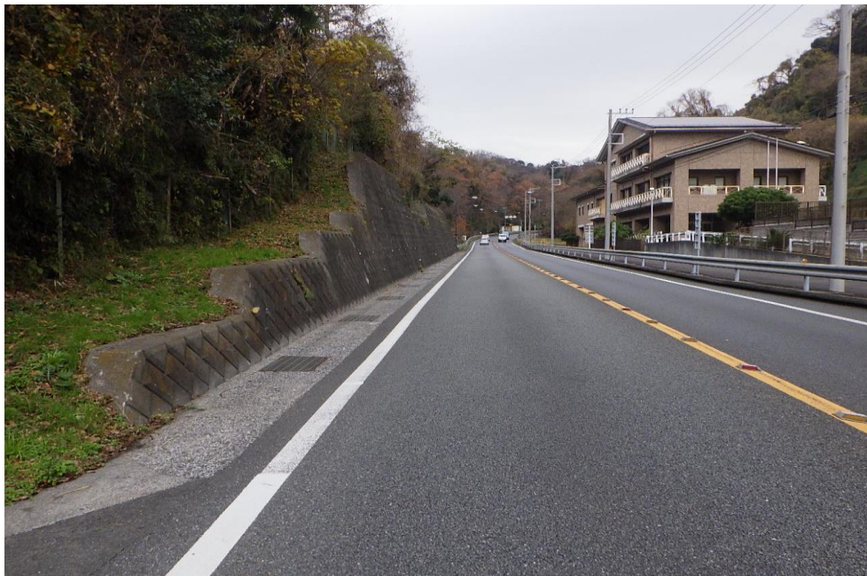
逗葉新道 ブロック積み補修工事
