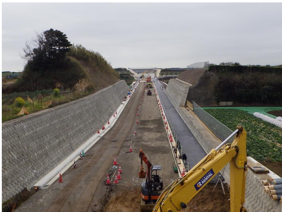
情報板設置予定位置全景（三浦方面に向かって撮影 2020.3.9）
