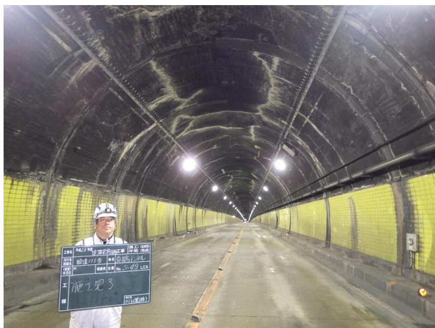
道路災害防除工事 真鶴トンネル完成
