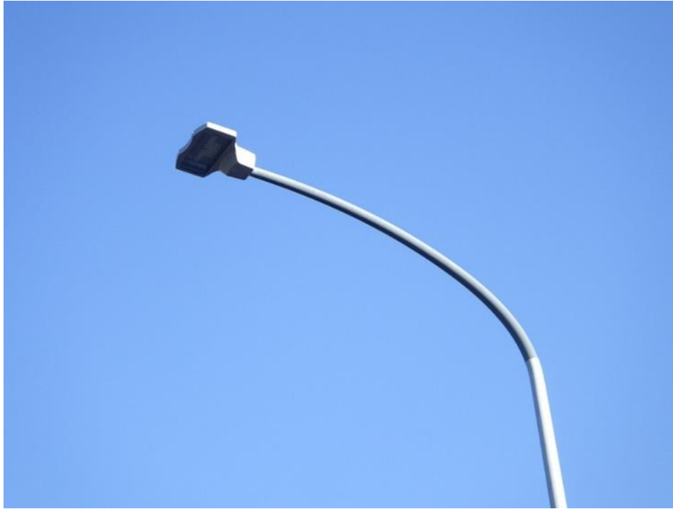
LED道路照明灯
