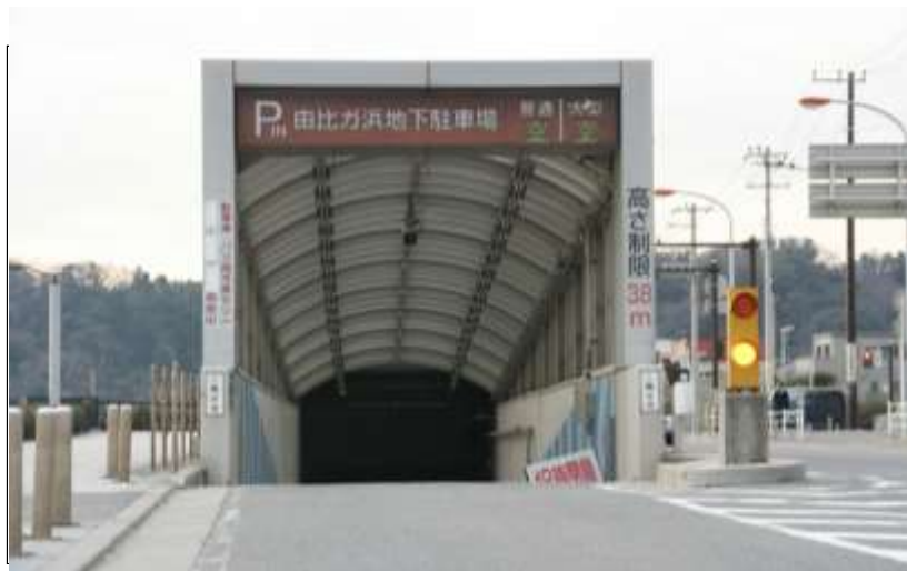
入庫口 I (海側)
