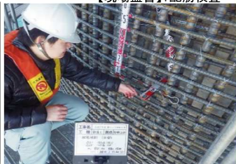
【現場監督】：配筋検査
