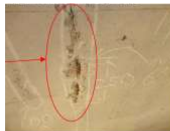
衣笠城趾トンネル（三浦縦貫道路） における変状状況（現在は対策実施済み）
