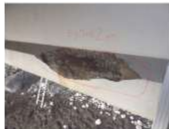
新吉浜橋（真鶴道路）における損傷状況 （現在は対策実施済み）
