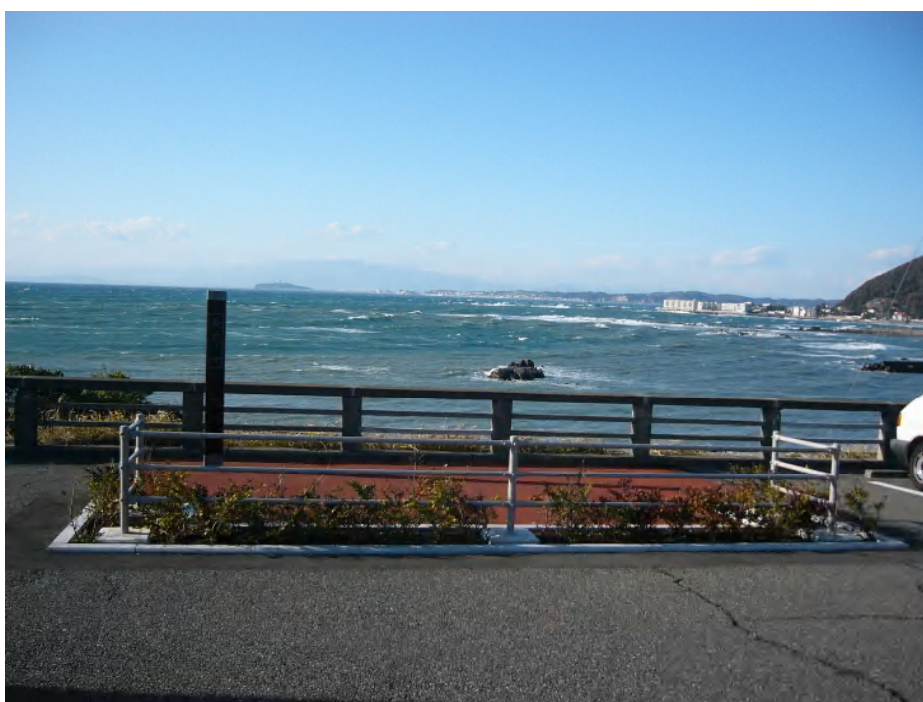
“とるば”撮影スポット（電線地中化工事後）
